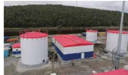
Система очистных сооружений
