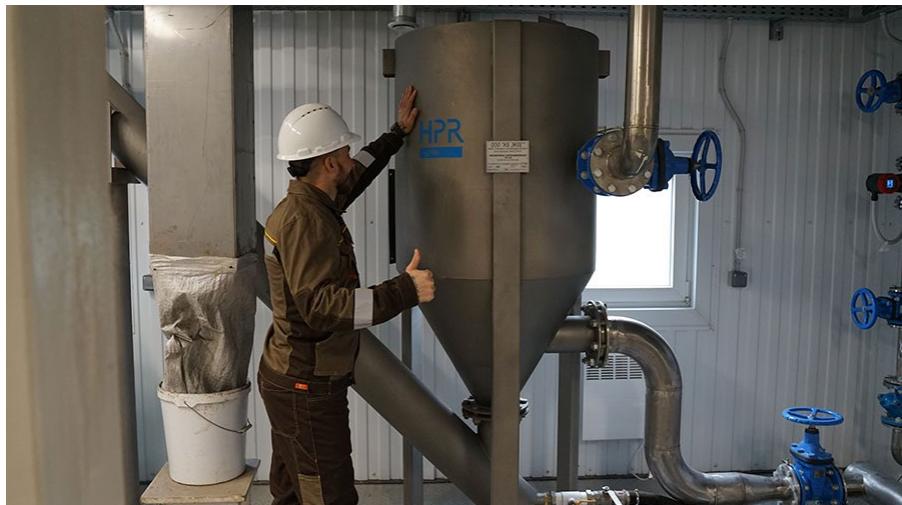
Общий вид песколовки
